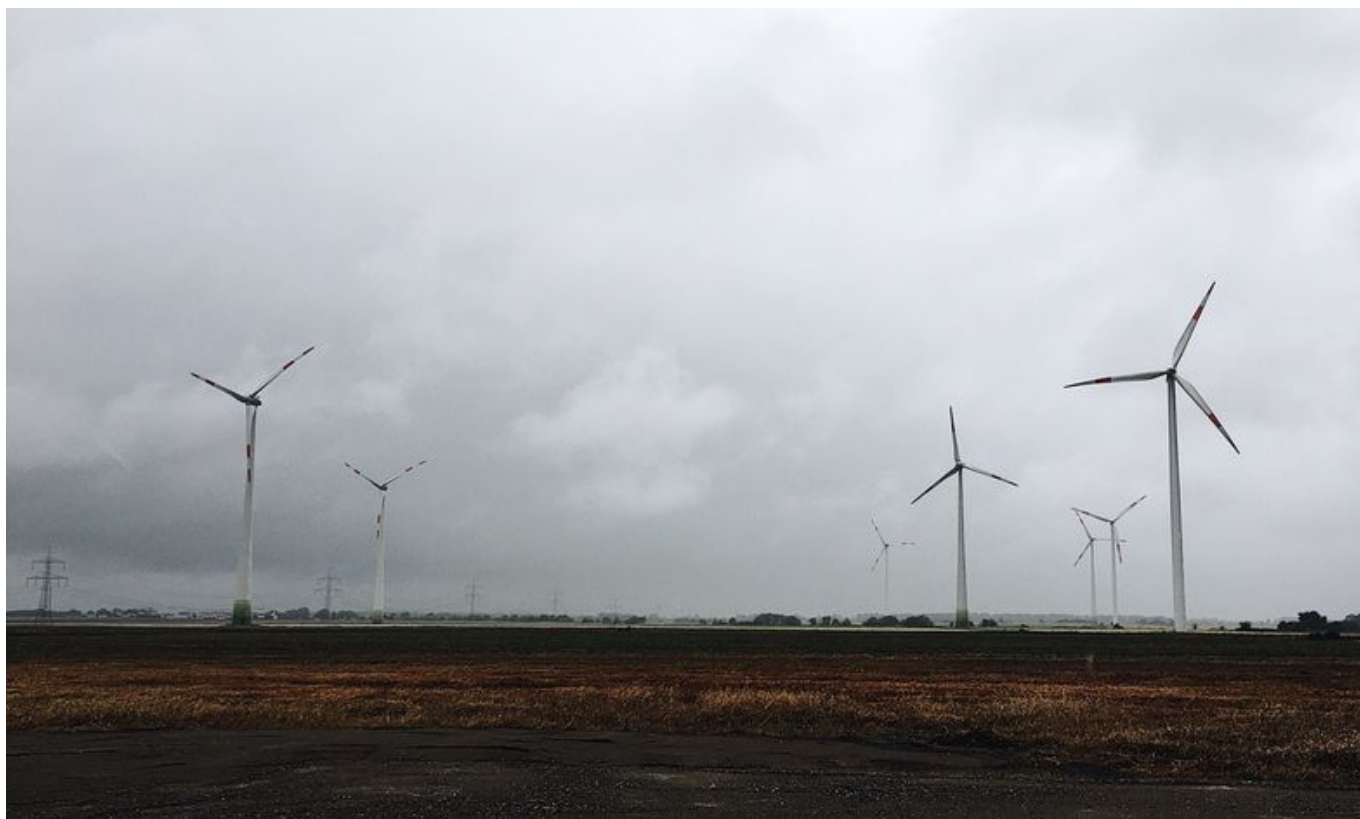
Farma wiatrowa w Rehfelde. Budowa dwóch wiatraków kosztowała lokalnych mieszkańców zrzeszonych w zielonej inicjatywie ok. 10 milionów euro.
